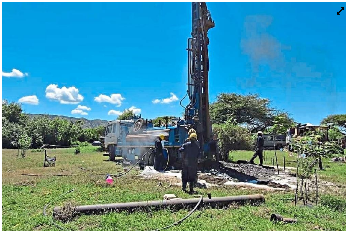
Mit einem riesigen Bohrer mussten die Arbeiter 120 Meter tief graben, um auf Grundwasser zu stoßen. - Foto: Frei
