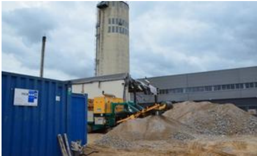
Der alte Späneturm des einstigen Möbelwerks soll im August fallen. Foto: Jaumann
