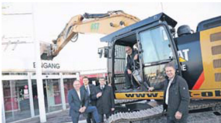
Damit fing alles an: Im November 2014 legte der Bagger am Römerpark los. Die Abrissarbeiten sind abgeschlossen, nun wird neu gebaut.
