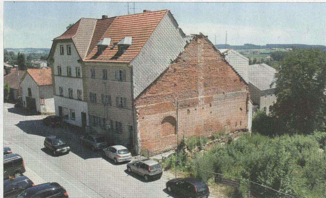
Abbruchreif sind die Gebäude südlich der Gartlbergstraße. An deren Stelle soll der Neubau für die KWA-Pflegeschule errichtet werden. – Foto: Wagle
