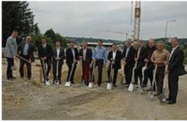
Gemeinsam beim Spatenstich für das neue Fachmarktzentrum an der Südeinfahrt: Vertreter von Investoren, Bauträger, Geschäftswelt und Stadt. – Foto: Esterer
