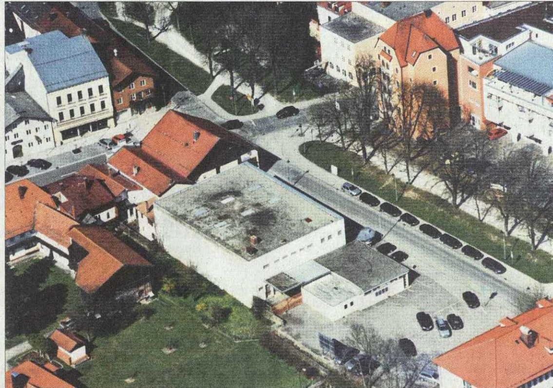
Eine moderne Norma-Filiale wird in der westlichen Ringallee errichtet. Zuvor muss das frühere Ringcenter, das jetzt leer steht, abgerissen werden. – Foto: Kirk
