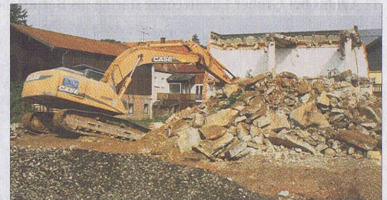
Das Ende: So sah die Baustelle gestern aus. – Foto: Miséré
