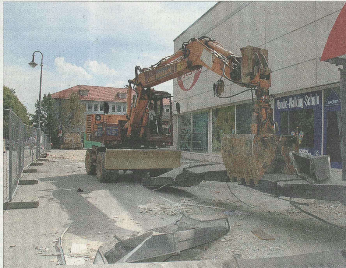
Die Bagger haben ihre Arbeit begonnen: In drei Wochen soll das frühere Ringcenter an der Ringstraße abgerissen sein. Im Anschluss wird sofort die neue Norma-Filiale errichtet. – Foto: Huber
