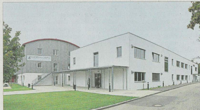
Der neue Erweiterungsbau (rechts) des European Campus Rottal-Inn, den der Landkreis für 3,45 Millionen Euro errichtet hat.
